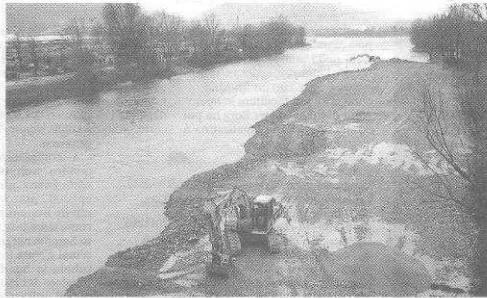
I lavori di escarazione del gennaio 2010, poi bloccati per l'eccessivo abbassamento dell'Adda.
